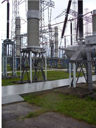
Obr. 5.2 Príklad vyvýšeného chodníka v elektrickej rozvodni
