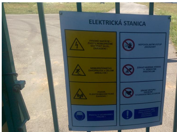
Obr. 5.1 Bezpečnostné označenie v elektrickej rozvodni
