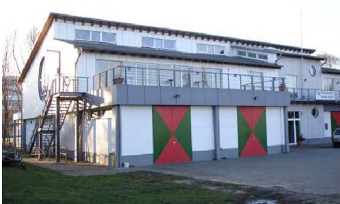
Obr. 4: Viacúčelová športová budova v mestskej časti Neukölln v Berlíne [Schulze]
